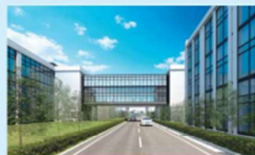
▲上空通路で既存建物とB棟を接続。
