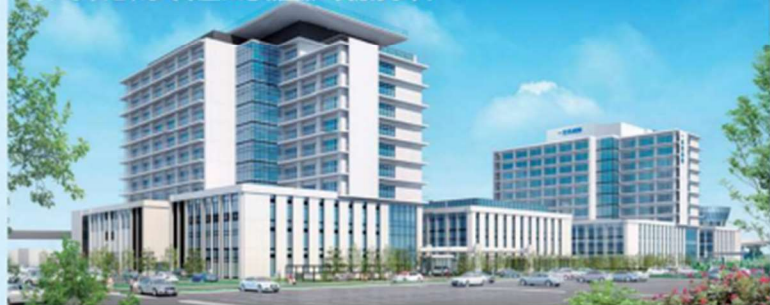
▲一宮西病院・新館B棟完成イメージ。屋上ヘリポートでドクターヘリの着陸も可能。
